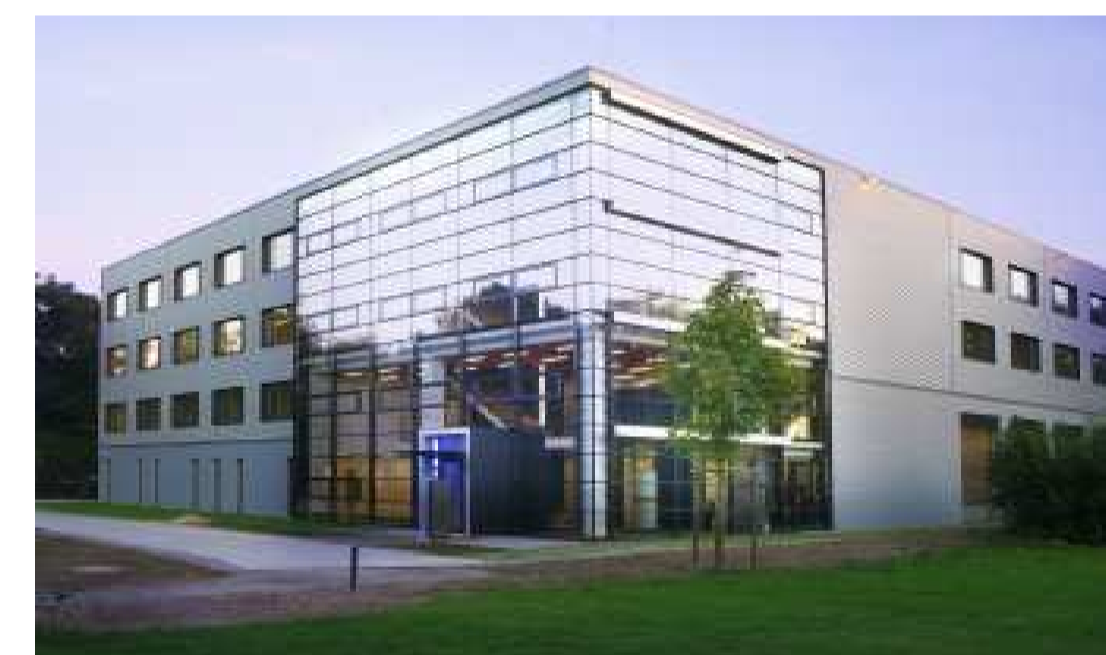
Fig. 8. Center for Fuel Cell Technology (Zentrum für BrennstoffzellenTechnik (ZBT) gGmbH) in Duisburg/Germany
